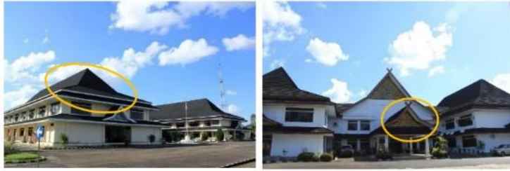
Gambar 2 Bubung Bangunan Dan Bentuk Ukiran Sumber: Dokumentasi Pribadi
